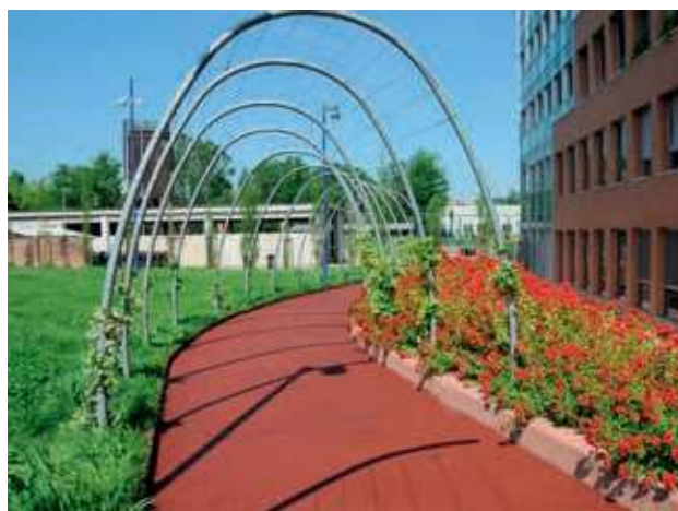
2010 – La struttura ad archi parabolici in ferro zincato su cui far arrampicare il falso gelsomino, con l'aiuto di cavi d'acciaio che ne guideranno la crescita. (Foto Marco Minari)
