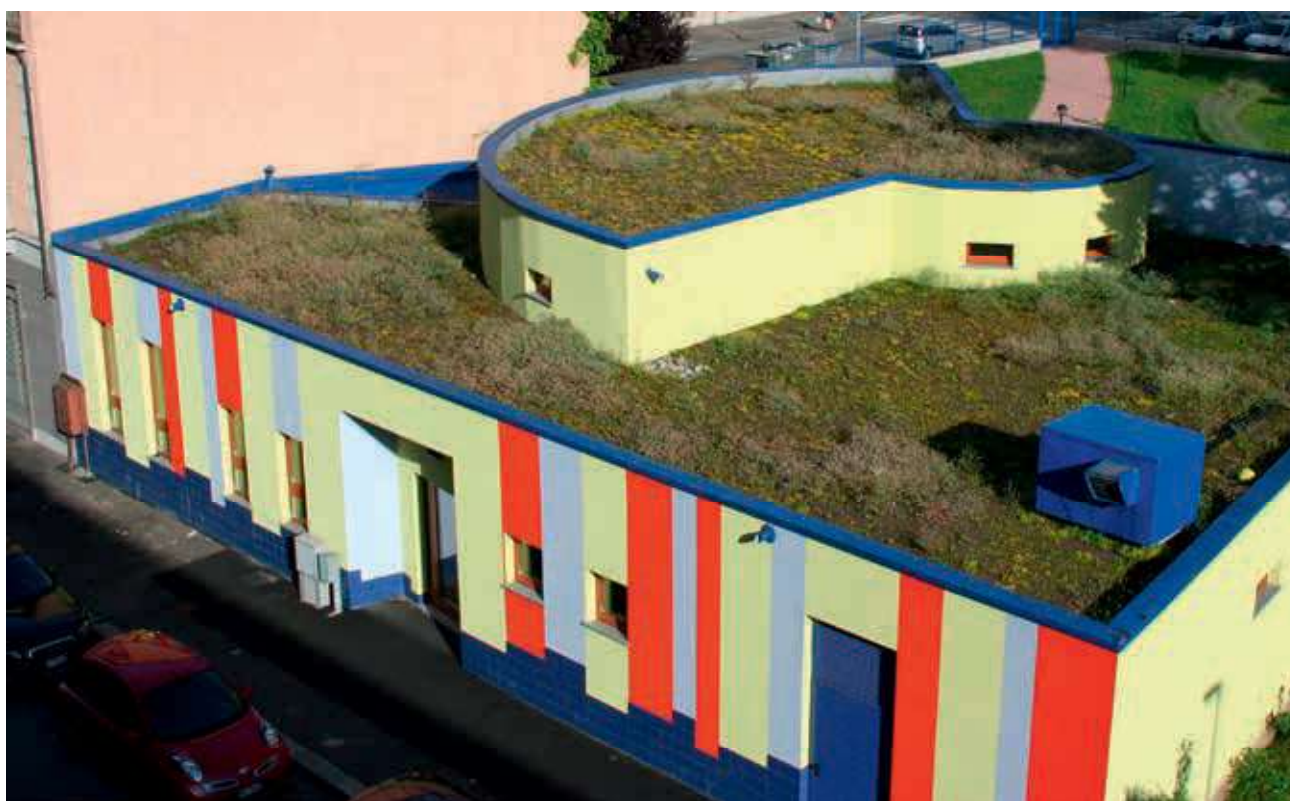
La copertura verde del tetto piano aumenta l'isolamento termico e acustico, maggior inerzia termica e diminuzione dell'isola di calore anche per gli edifici vicini e utilizza le acque di pioggia per irrigare naturalmente il Sedum, pianta molto rustica dalle minime esigenze manutentive. (Foto Marco Minari)
